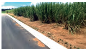
路肩コンクリートブロック
